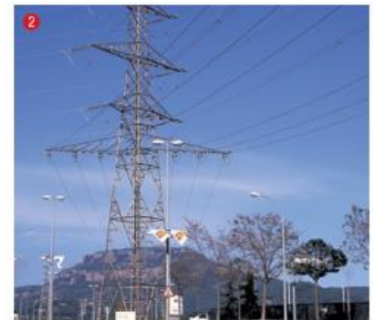
Estructura de barras triangulada.
