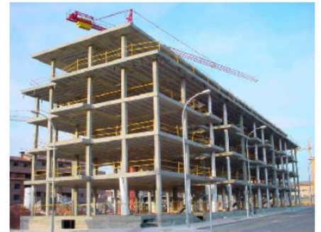
Fig 13: Ejemplo de estructura entramada.
